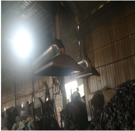
图 3 切条打块集气罩
