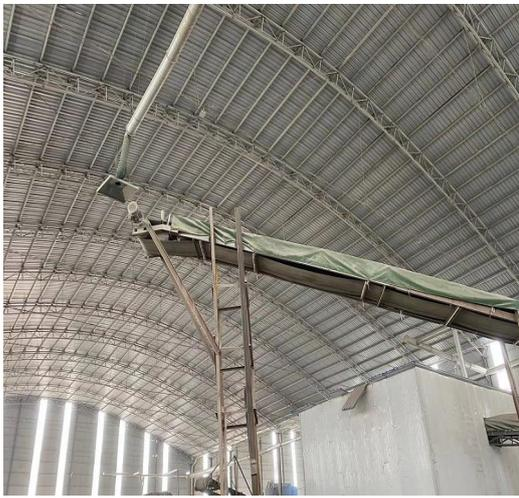
图 16 皮带机出料口设集气罩
