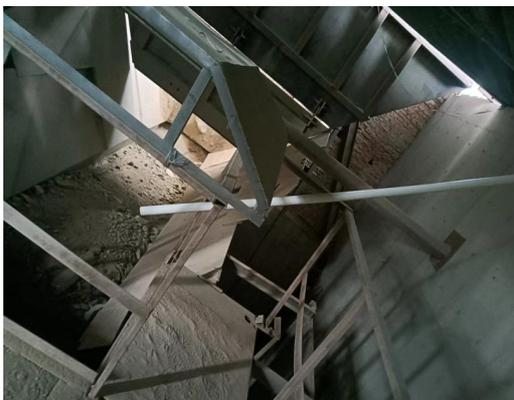
图9 粗破机上方设水喷淋头
