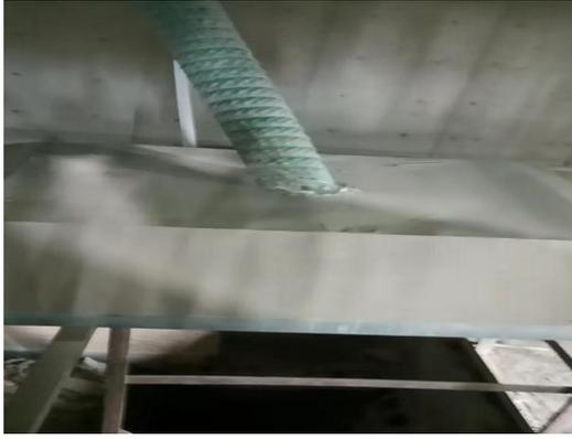
图 13 粗破机进口上方设集气罩
