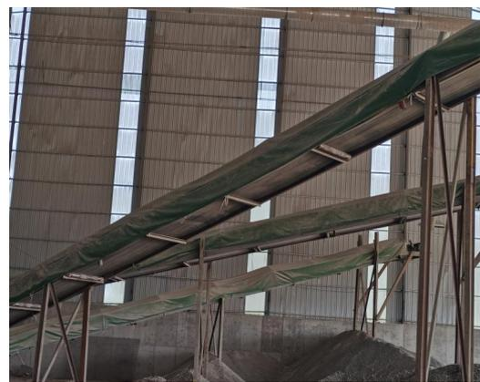
图 12 运输带封闭罩
