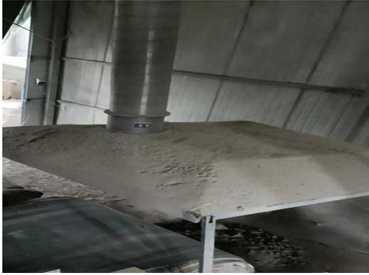
图 14 粗破机出口上方设集气罩
