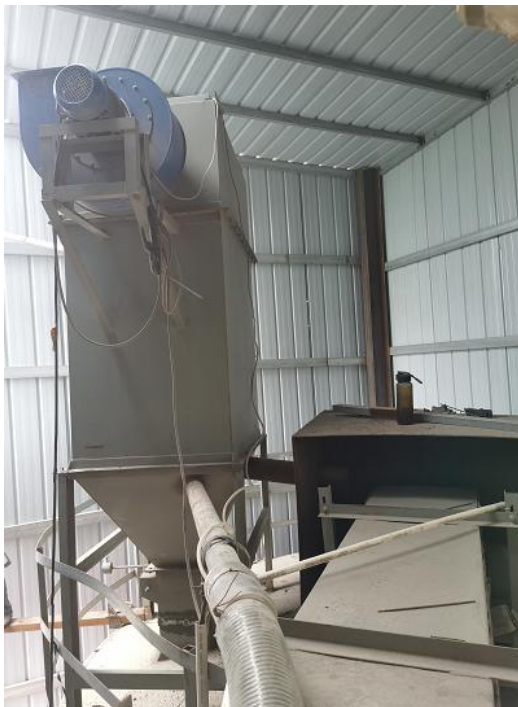
图 9 200t、100t 混合仓共用 1 台除尘器 TA004
