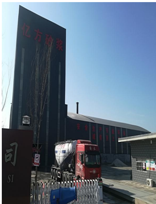
图 19 封闭搅拌楼、封闭原料库
