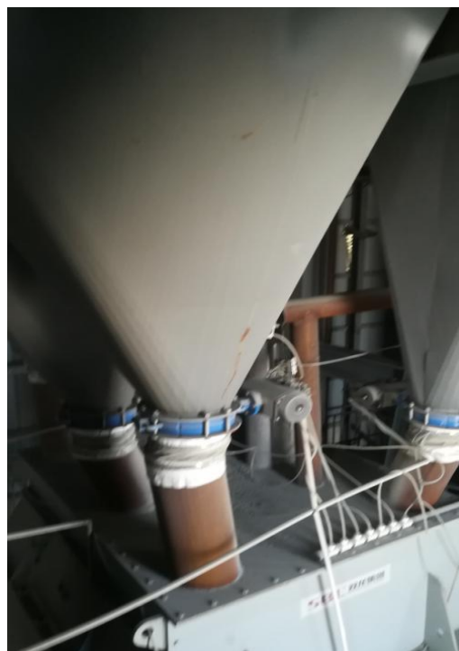
图 12 细、中、粗沙仓原料输送管道密闭
