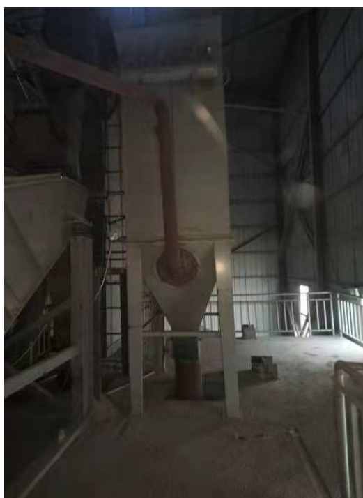
图 11 二次筛分、中粗细仓粉尘除尘器 (TA005)
