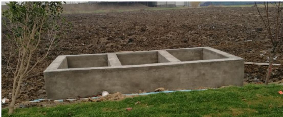
图 6 车辆清洗废水三级沉淀池
